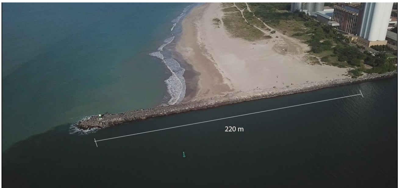
Imagem 02: Foto aérea do dique do município de Cabedelo.
